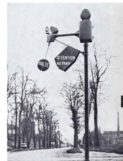
La Revue Générale des Routes et de la Circulation de février 1926 consacre un premier et long article au Wig-Wag. Déclenché automatiquement par la locomotive quelques centaines de mètres avant le passage à niveau, le système du Wig-Wag « à la française » attire l'attention de l'automobiliste à la fois par le balancement d'un disque rouge portant une lampe électrique, par le déclenchement d'une sonnerie puissante, et par une seconde lanterne rouge, placée au-dessus du disque et qui se trouve, tour à tour, masquée et démasquée.
