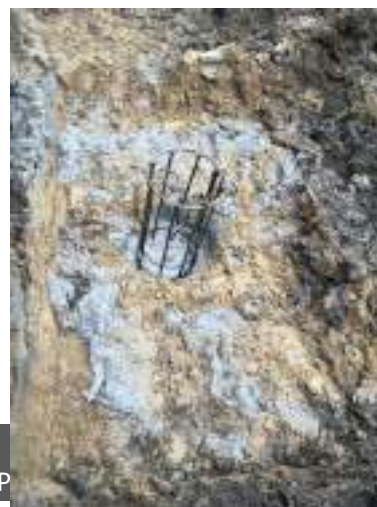
Pieux forés tarière creuse
