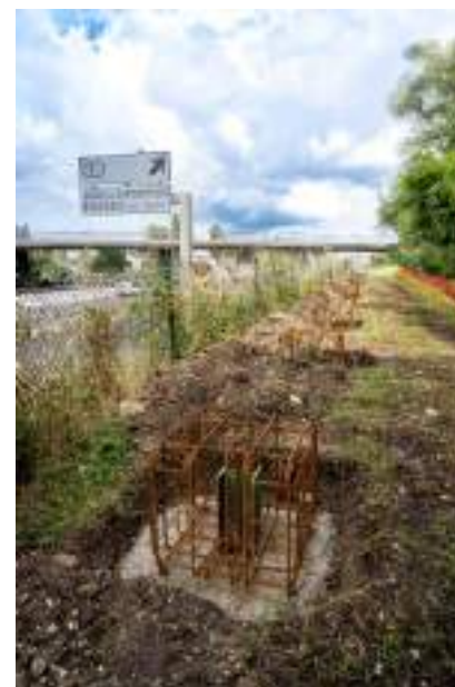
Pieux vibrofoncé et massif tête de pieu
