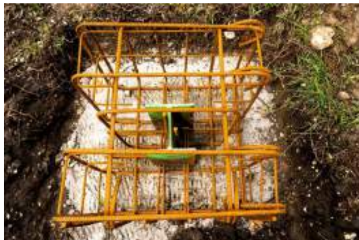
Pieux vibrofoncé et massif tête de pieu
