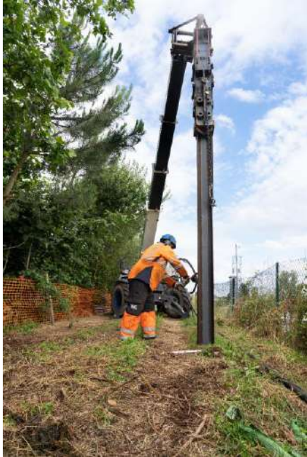
Pieux vibrofoncé et massif tête de pieu
