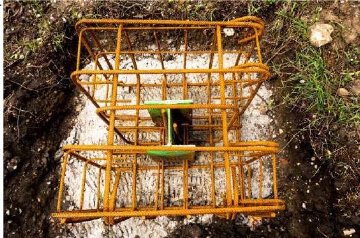
Pieux vibrofoncé et massif tête de pieu
