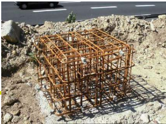
Massif tête de pieux et Longrine de soubassement
