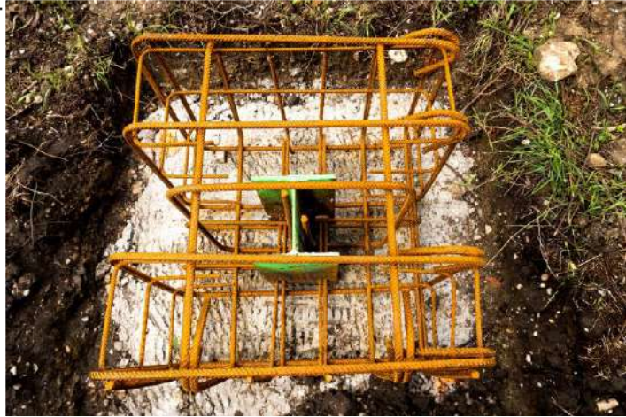
Pieux vibrofoncé et massif tête de pieu
