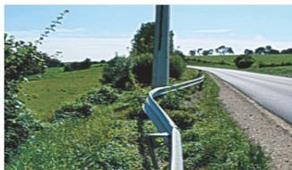
L'arrêté précise les performances et les conditions d'implantation des dispositifs de retenue routiers sur les voies dont la limitation de vitesse est supérieure ou égale à 70 km/h
